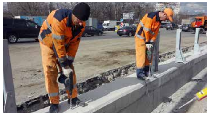
Монтаж стоек барьерного ограждения (развязка Дмитровского шоссе, Москва, 2012 г.)
