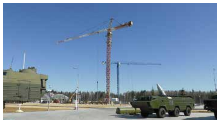
Монтаж башенных кранов и металлоконструкций к железобетонным фундаментам на объектах специального назначения (РФ, 2016 г.)
